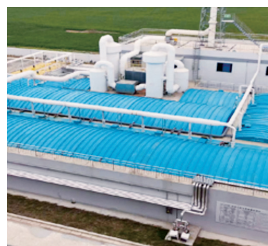
蘇州二葉污水站
