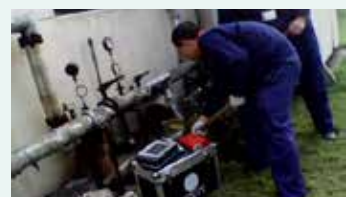
济民肿瘤医院检漏现场
