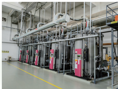
奥鸿药业锅炉改造
